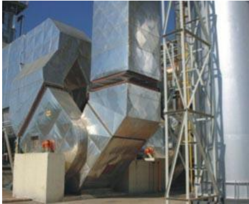
Exaustor de Tiragem Induzida para caldeira de queima de Madeira: Potência 500.HP
