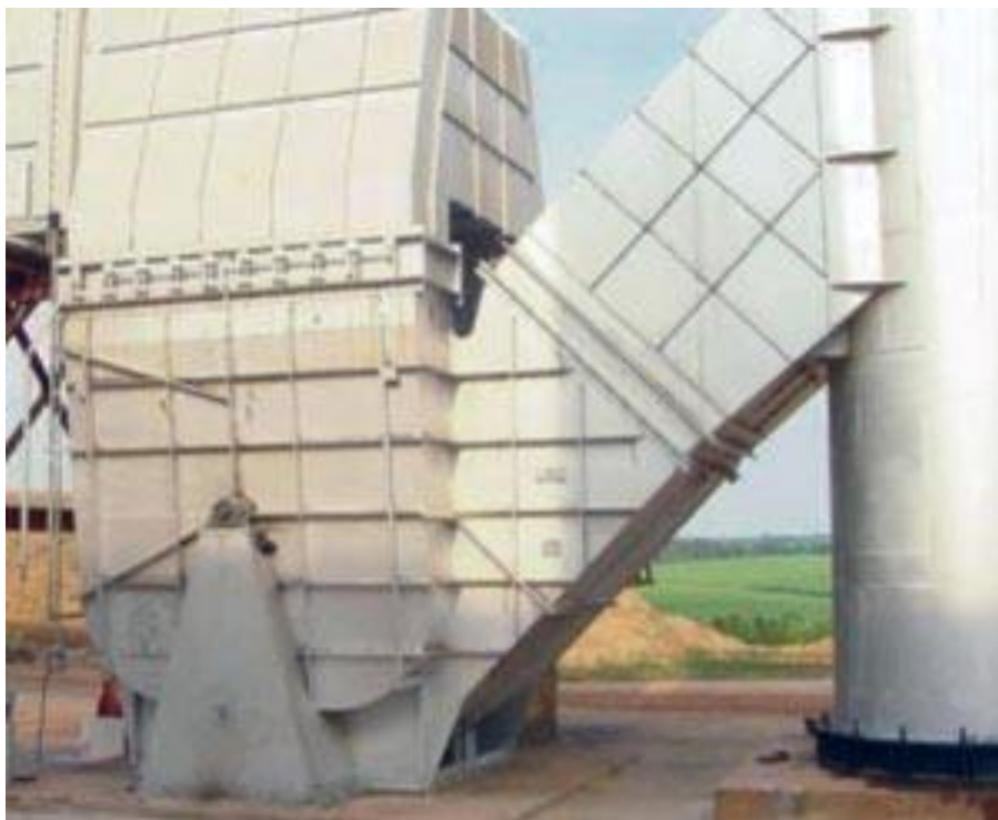
Exaustor de Tiragem Induzida para caldeira de Bagaço de Cana-Potência: .HP
