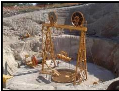
Figura 33: Pórtico e plataforma de trabalho para poço de 400m de profundidade
