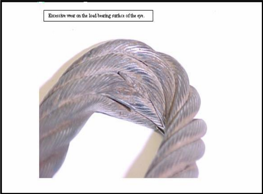
Figura 95: Cabo de aço desgastado
