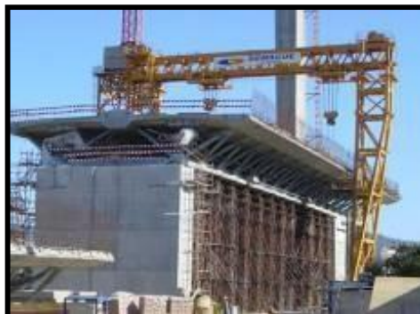
Figura 34: Pórtico de 180ton para colocação de aduelas
