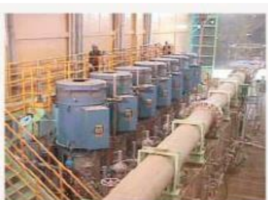
Fornecimento: MGF8809, 930 kW, 4160 V, 2 pólos Aplicação: Bombas
