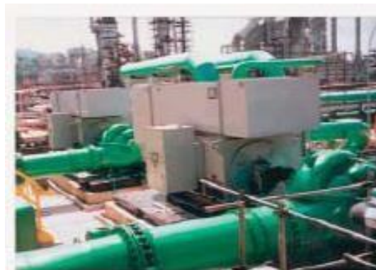
Fornecimento: MGF630, 1070 kW, 13200 V, 8 pólos Aplicação: Bombas
